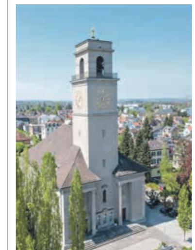
Kirchturm Bergli Kirche: 48 Meter (bis Dachspitze)
