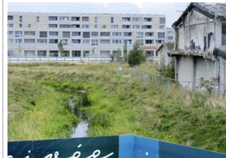
Der Schwärzibach wird um einige Meter westlich verlegt. lg
