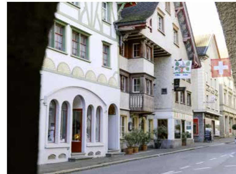
An der Hauptstrasse 13 ist wieder Leben eingekehrt, in der ehemaligen Metzgerei Meierhofer wird dies noch eine Weile dauern. lg
