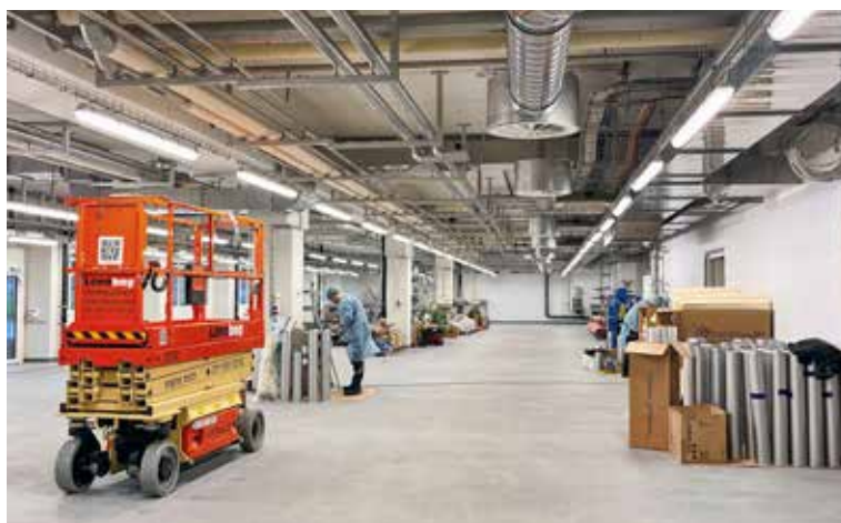
Die neuen Produktionshallen der Hügli Nahrungsmittel AG werden bis Juli 2024 nach und nach mit den Produktionsanlagen aus St. Gallen ausgestattet. z.V.g.
