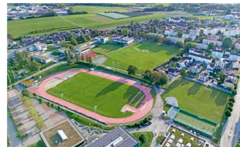
In die erste Sanierungsetappe fällt der Neubau des Kunstrasenspielfeld West, die Sanierung Naturrasenspielfeld Ost und des Korbballfelds sowie Umgebungsarbeiten und die Erneuerung der Beleuchtungsanlage. Bild: Kevin Fitzli
