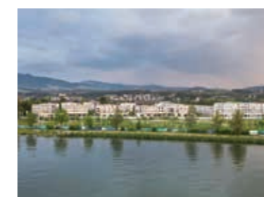
Im Herbst sollen die Tiefbauarbeiten für das «Arrivéé» starten. Kevin Fitzz
