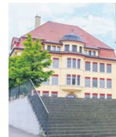
Am Schulhaus Reben 25 stehen Sanierungsarbeiten an. kim
