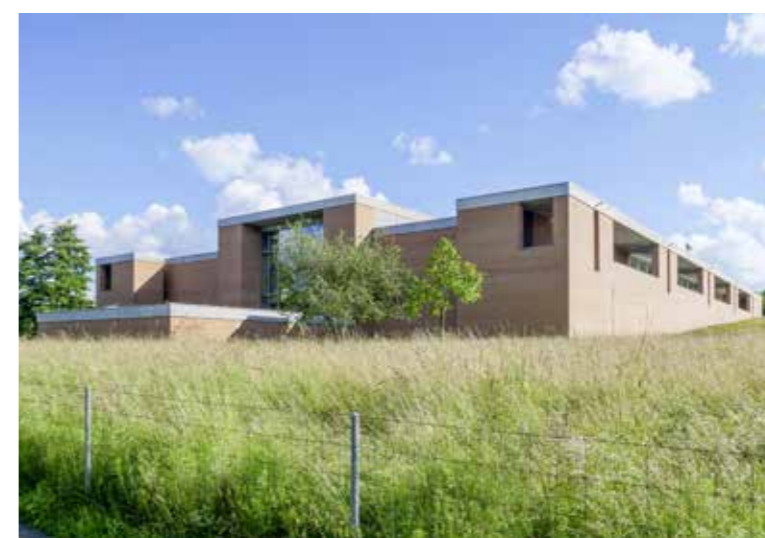
Ein potentielles Objekt des IDEGO: Das Seewasserwerk Frasnacht. z.V.g.
