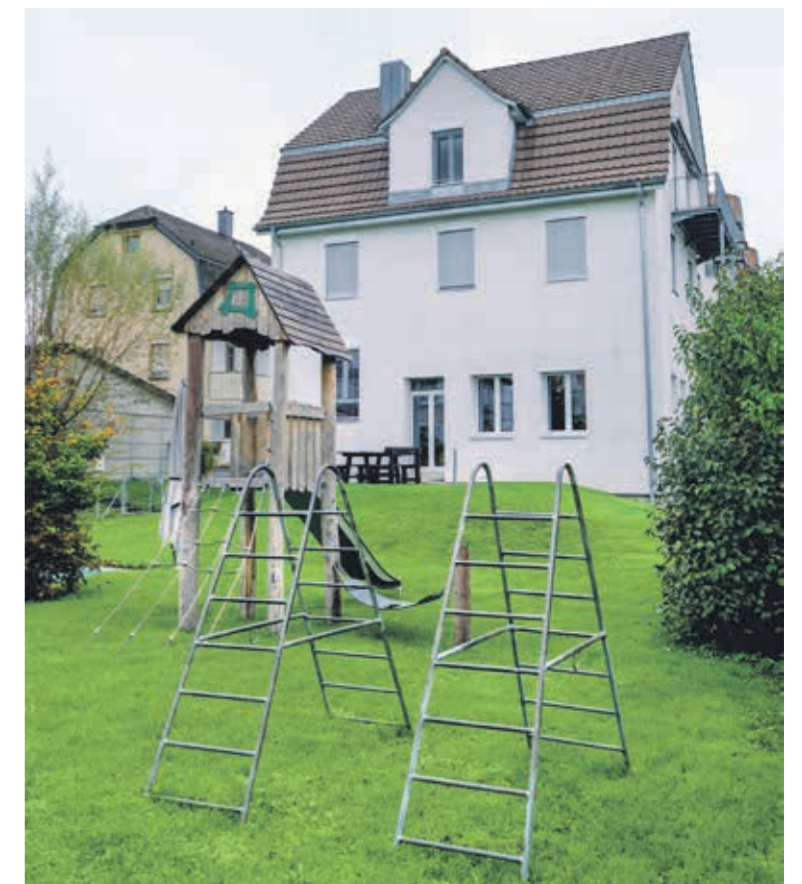
Bis 2030 benötigt die PSG Arbon drei neue Kindergärten. Einer davon ist in der eigenen Liegenschaft an der Brühlstrasse 36 vorgesehen. kim
