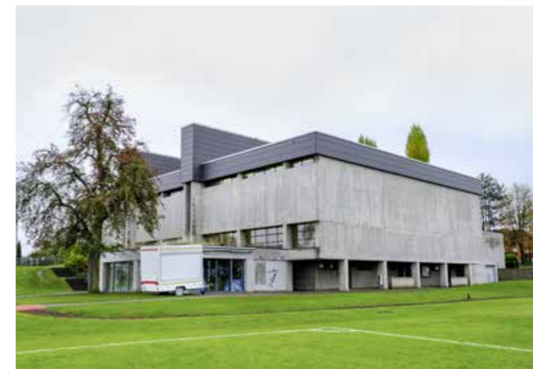
Das Turnhallen-Gebäude von 1972 ist dringend sanierungsbedürftig. lk
