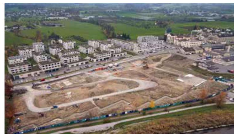
Die Untergrundarbeiten auf dem «Arrivée»-Areal laufen nach Plan. Kevin Fitz
