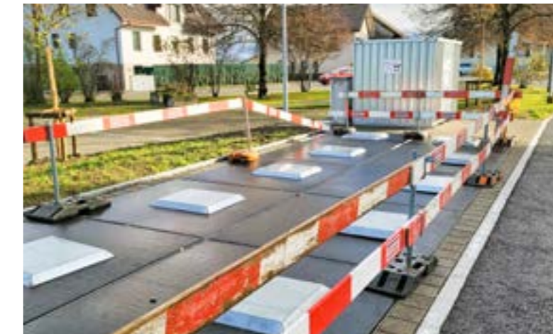
Am Mittwoch befand sich die neue Sammelstelle noch im Bau.
