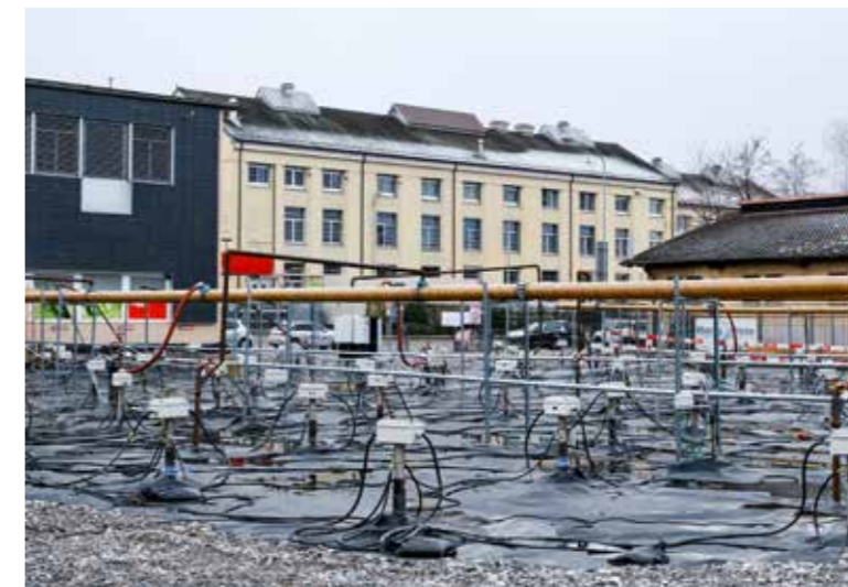
Im Jahr 2023 wurde das Raduner-Areal thermisch saniert. Dabei wurde der Untergrund mit Heizelementen auf über 100 Grad aufgeheizt. Archiv
