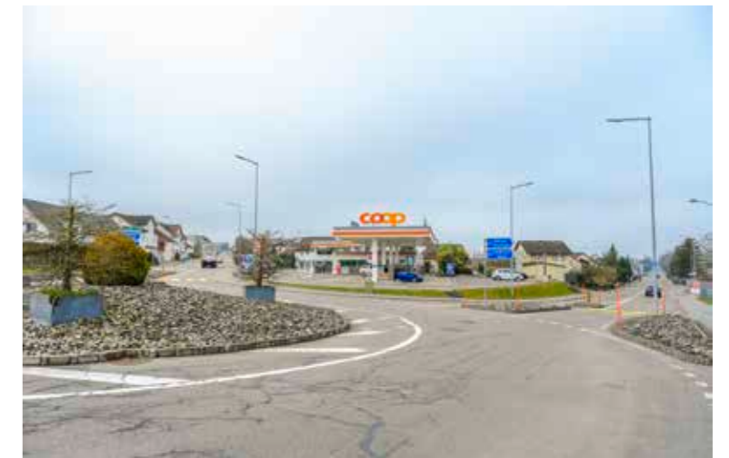
Auf der Amriswiler- und der Egnacherstrasse wird demnächst gebaut. lk
