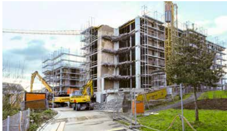
Die eingestürzten Balkone im Seemoosriet werden saniert. maz
