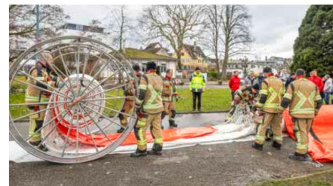
Die Deichelemente aus dem Container werden verlegt und mit der orangen Plane abgedichtet. Bei der Demonstration sind die Schläuche mit Luft gefüllt, im Ernstfall wäre es Wasser.
