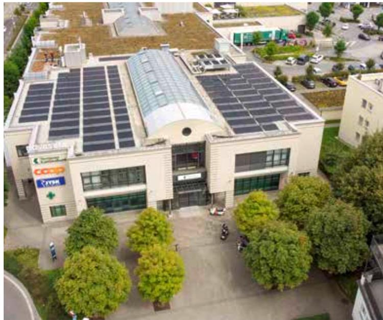
105 000 Kilowattstunden grüne Energie: So viel produziert die neue Photovoltaikanlage auf dem Dach der TKB Arbon jährlich. z.V.g.
