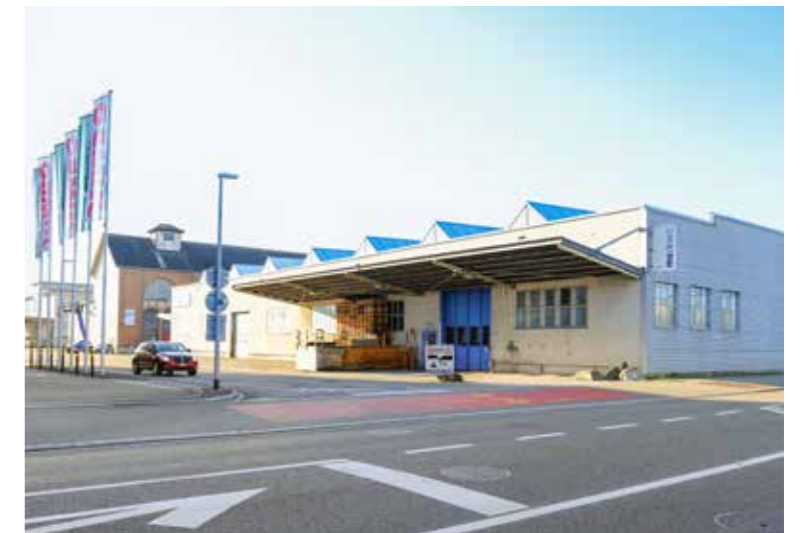
In den ehemaligen Büroräumen der «MS Direct» an der Textilstrasse soll der Arboner Jugendraum entstehen. Das Gebäude befindet sich im Besitz der HRS. /k
