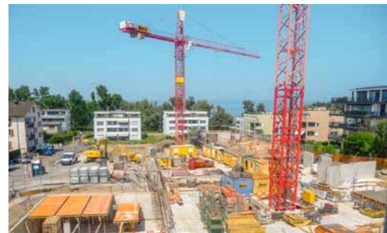
Das Fundament der Siedlung Ziegelhütte mit insgesamt 72 neuen Wohnungen ist gelegt. In einer ersten Baueinheit werden 45 davon realisiert. mm
