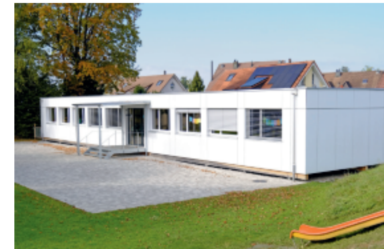
Ein gleicher Modulbau soll das bestehende Provisorium ergänzen.
