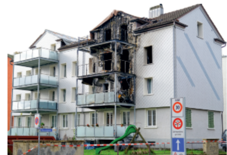
Alle acht Mietparteien müssen in den kommenden drei Wochen geräumt werden, damit die Arbeiten am Haus vorangetrieben werden können. mm
