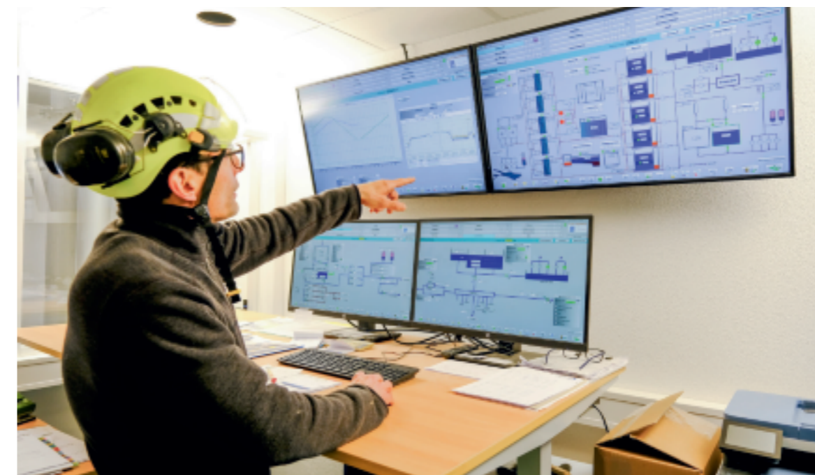
Roger Thoma erklärt in der «Schaltzentrale» des Seewasserwerks die Steuerung und die Abläufe. sam
