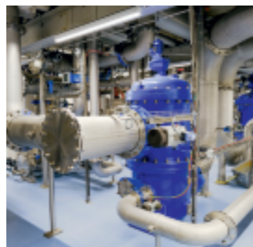
Beim Rundgang durch das Seewasserwerk kommt man an den verschiedenen Aufbereitungsstufen vorbei: dem Grobfilter, dem Biofilter und der UV-Anlage (v.l.n.r.). sam
