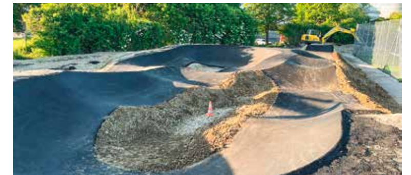
Der Pumptrack in Frasnacht wird in den nächsten Wochen fertiggestellt. z.V.g.
