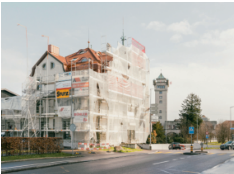
Die Villa während der denkmalgerechten Sanierung.
