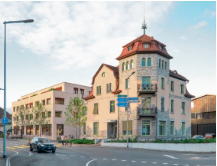
Der sanierte «Breitehof» an der Romanshonerstrasse 4.
