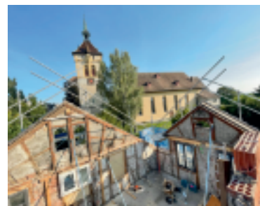
Das Hotel «Müllers» wurde saniert. z.V.g.
