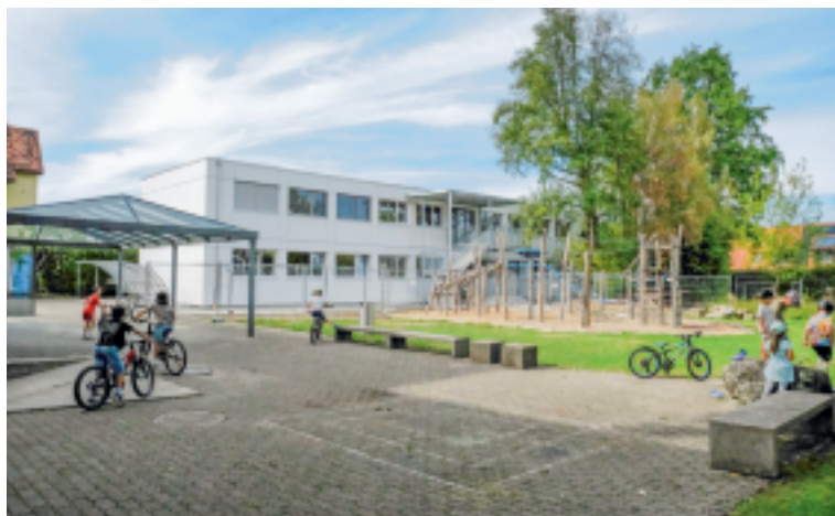
Das bestehende Schulhaus-Provisorium in Stachen wurde um ein Stockwerk ergänzt. Der Komplex steht neu dort, wo früher der alte Kindergarten war. sam
