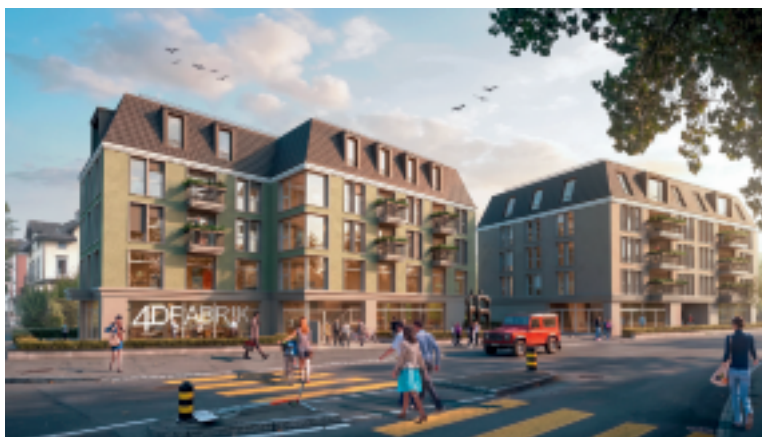
Zwischen der Überbauung Rosengarten und dem geplanten Projekt Stadthof entsteht aktuell auf einer Fläche von 1862m 2 eine Überbauung mit zwei Mehrfamilienhäusern. Die bestehenden Gebäude (oben rot markiert) werden abgerissen.
